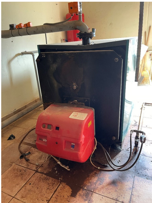
Σχήμα 1. Μονάδα λέβητα-καυστήρα 1 ου Δ.Σ. Σουφλίου
