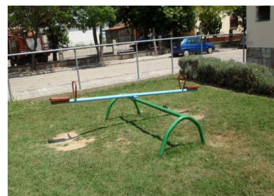
Επικίνδυνες κατασκευές, όργανα εκτός προδιαγραφών, μη επαρκής επιφάνεια απορρόφησης κραδασμών - άμμος λανθασμένης κοκκομετρίας
