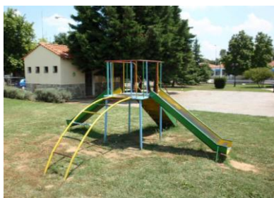
Επικίνδυνες κατασκευές, όργανα εκτός προδιαγραφών, μη επαρκής επιφάνεια απορρόφησης κραδασμών - άμμος λανθασμένης κοκκομετρίας
