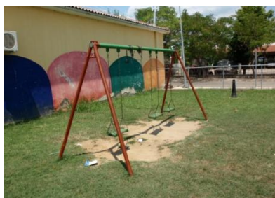
Επικίνδυνες κατασκευές, όργανα εκτός προδιαγραφών, μη επαρκής επιφάνεια απορρόφησης κραδασμών - άμμος λανθασμένης κοκκομετρίας
